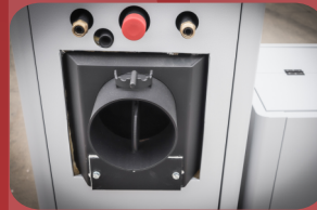
Dimovod i izvodi kotla
